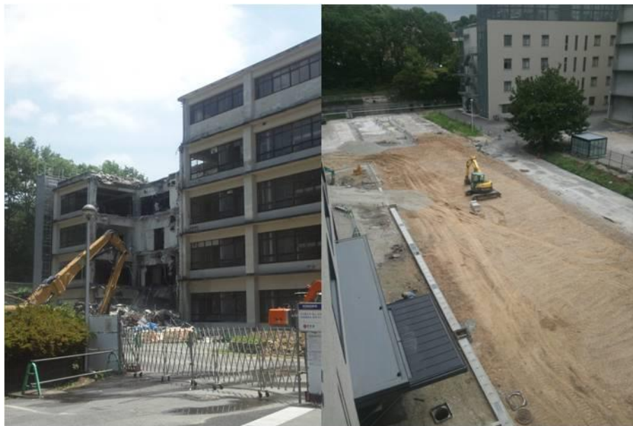
旧棟の取り壊し工事の様子(左:2013年6月中旬撮影)と、新棟4Fのミーティングルームにあるテラスから撮影した更地となった旧棟跡地(右:2013年8月撮影).
